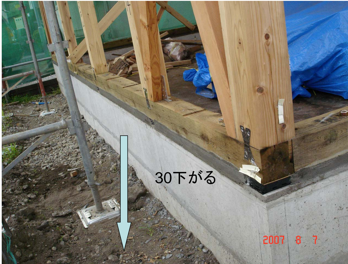
建売住宅新築中。べた基礎が不同沈下により北側寄りに30下がる。土台と基礎の隙間にモルタル詰め。地盤は砂地、周りに液状化により砂噴出の跡あり。
