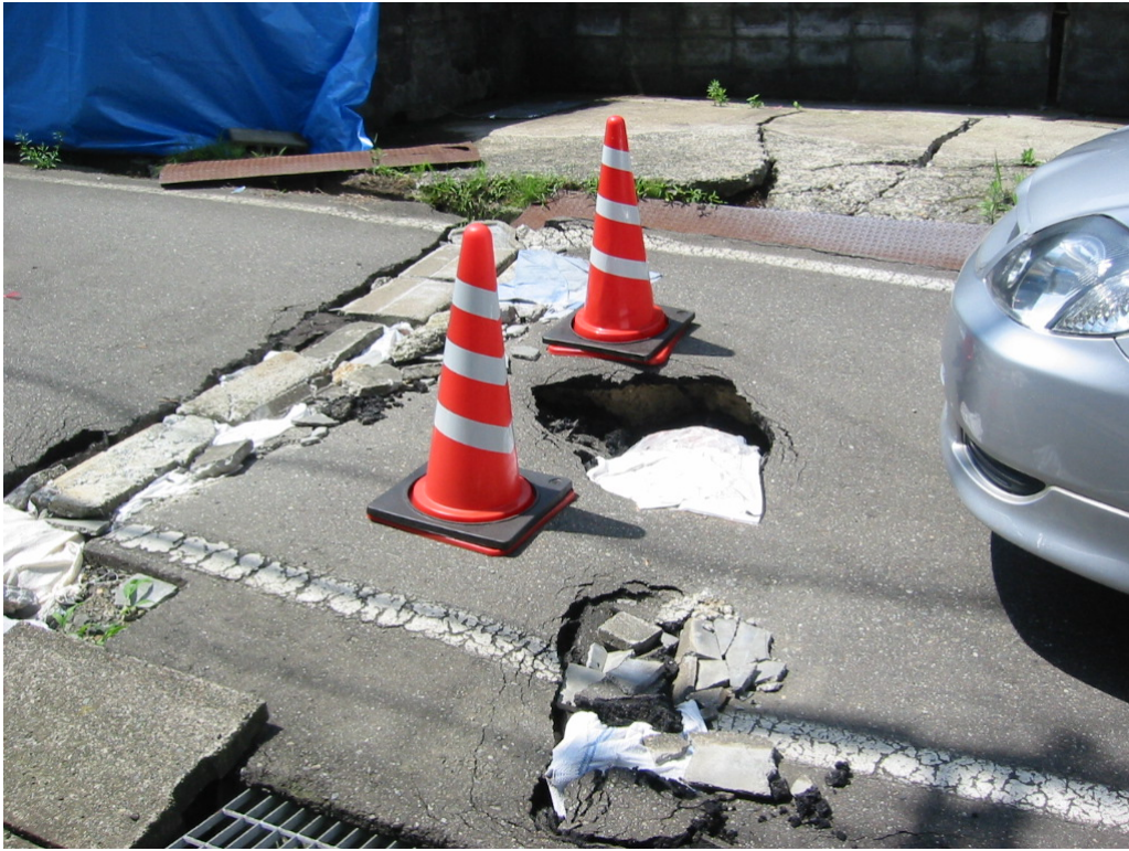
全面道路 砂地のため液状化により陥没
