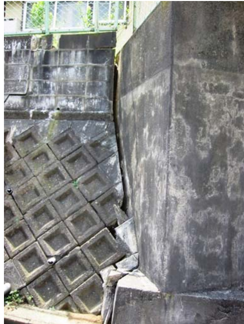
全面道路 砂地のため液状化により陥没
